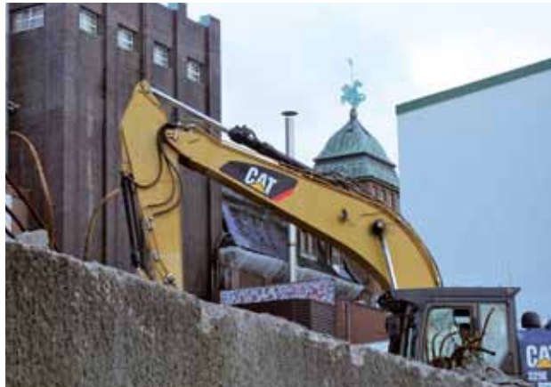
Noch wird hier gebaggert, aber wie geht es weiter?
